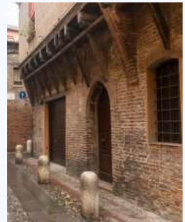
Tipica casa a sbalzo in via Ragno a Ferrara
